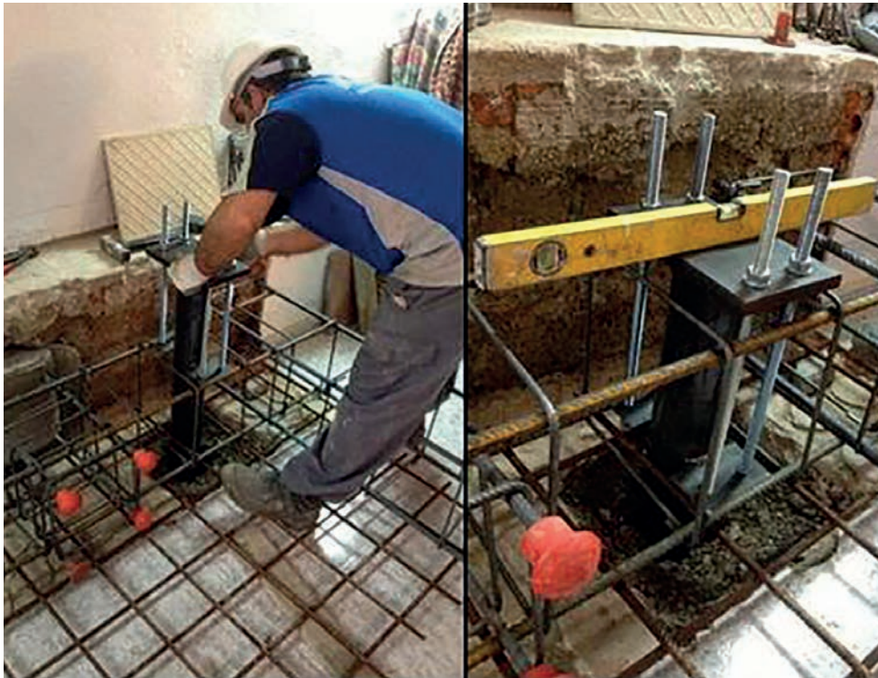
Figura 11. Instalación de aparato CSAP en nueva cimentación. 2PE Pilotes SL, 2014.
