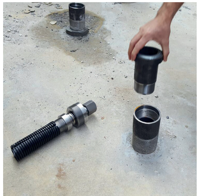
Figura 16. Casquillos usados para anclaje del sistema de hincado. Cortesía de Geonovatek, 2017.
