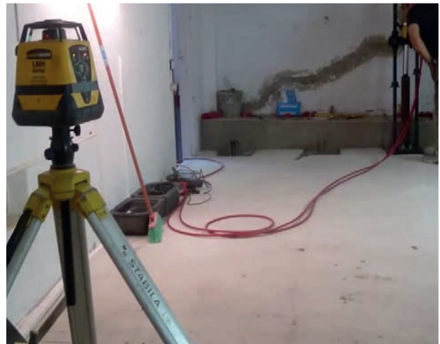
Figura 13. Control topográfico de movimientos. 2PE Pilotes SL, 2014.
