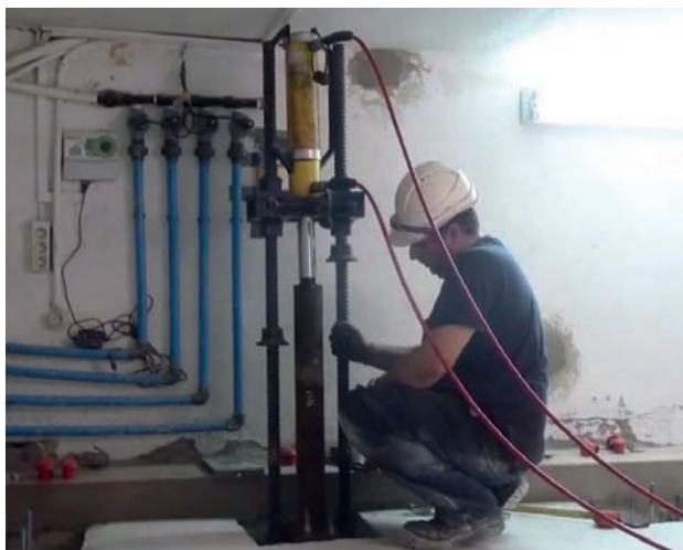
Figura 12. Hincia del micropilote en espacio con gálibo reducido. 2PE Pilotes SL, 2014.
