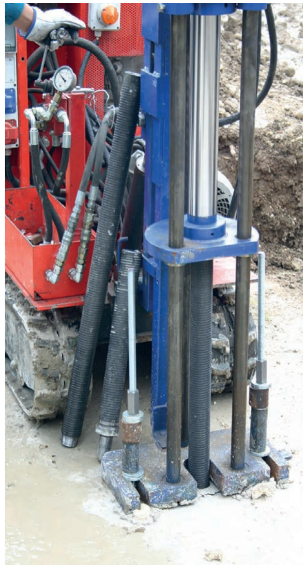
Figura 15. Hincado del micropilote. Cortesía de Geonovatek, 2017.
