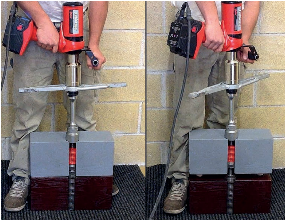
Figura 17. Elevación de la cimentación con dispositivo de precarga regulable. Cortesía de Geonovatek, 2017.
