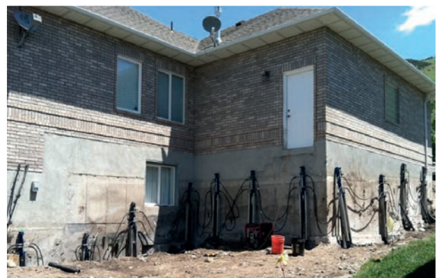
Figura 7. Recalce de vivienda en Salt Lake City (EEUU). Cortesía de Interwest y Magnum Piering Inc, 2017.
